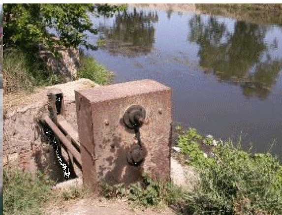
Figure 11 : Actuelle prise d'eau sur le canal Mahmoudia du canal
