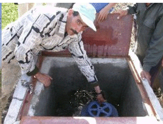
Figure 13 : Vanne alfa-alfa actionnée par l'opérateur
